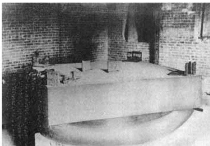
El interferómetro utilizado por Michelson y Morley.
